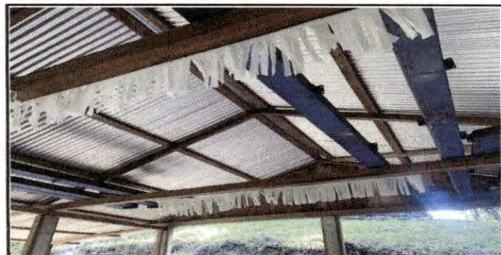
Foto 10: Interior de estructura del modulo 2.
